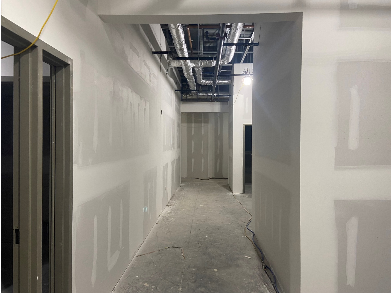
Admin. Bldg. – Drywall Installation
